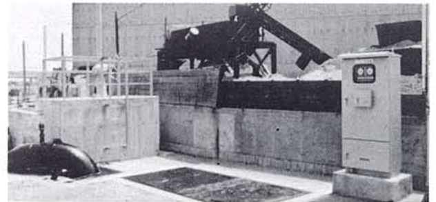
新浜仮排水機場の地上部
