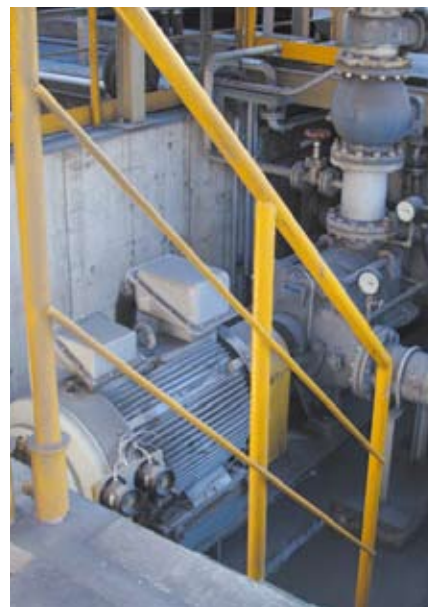
DOXは陸上ポンプの後方で稼動
