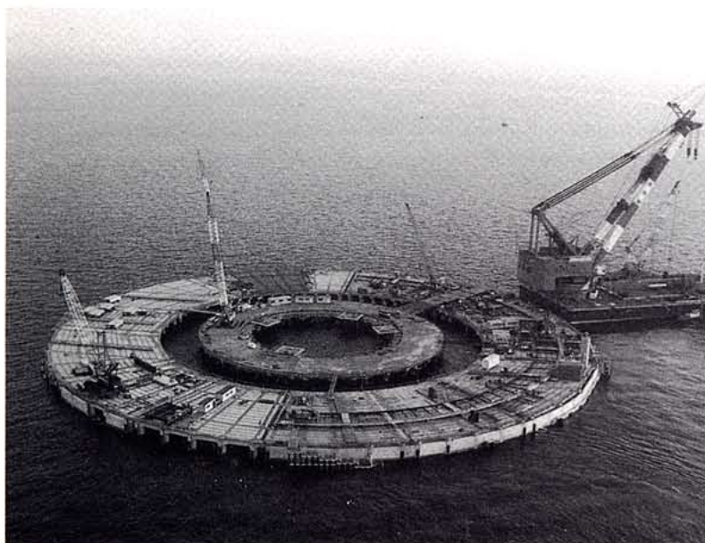
川崎人工島外部リング(外径200m)
